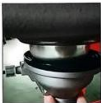
4: Conectați scurgerea în deschiderea circulară a chiuvetei și strângeți-l
