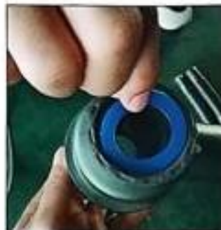
10: Puneți inelul de etanșare pe această îmbinare a conductei
