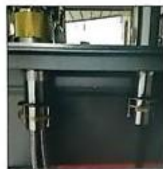
3. Introduceți cele două conducte de intrare a apei în robinet, acordând atenție poziției conductelor de apă caldă și rece
