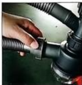
12: Puneți inelul de etanșare din silicon pe conexiunea cu conducta noastră de canalizare și strângeți conducta principală a furtunului
