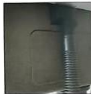
7: Alineați cu deschiderea chiuvetei, observați orificiul filetat de scurgere
