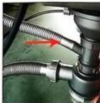
13: Acoperiți conducta de scurgere în conducta de canalizare, strângeți și ajustați
